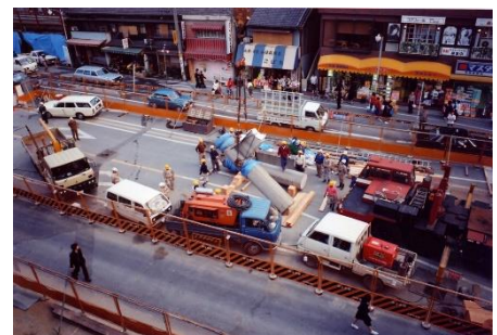
大鳥居の移転作業 (昭和57年)
